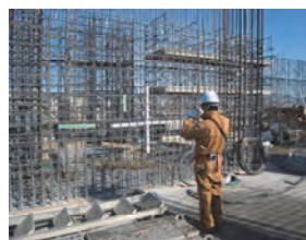
配筋写真(マーカーと背景をセット)
