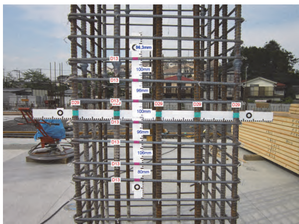
図-12 柱筋への適用
