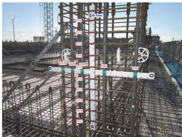
図-13 柱筋への適用
