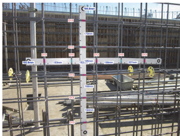
図-14 壁筋への適用
