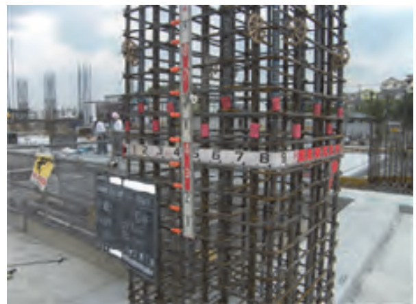
図-1 配筋検査写真例
