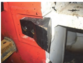
写真-3 再利用ビット取付状況
