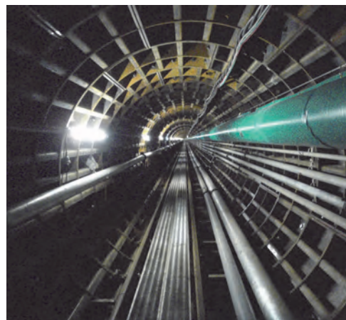
写真-1 トンネル坑内状況
