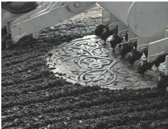
写真-3 マンホール部施工状況
