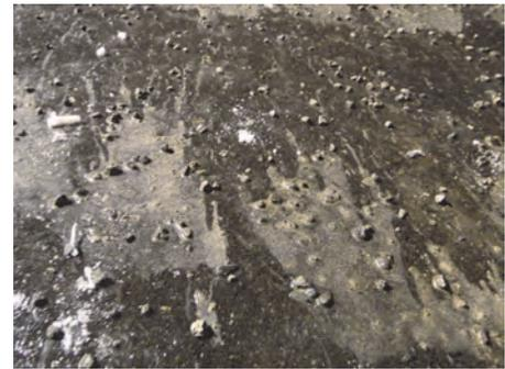
写真-6 水膜路面における加热水混合散布施工路面の一例
