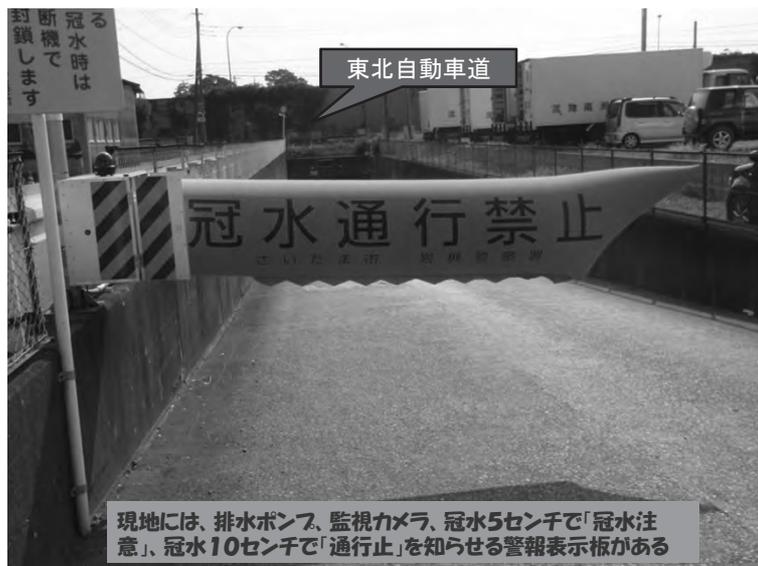
現地には、排水ポンプ、監視カメラ、冠水5センチで「冠水注意」、冠水10センチで「通行止」を知らせる警報表示板がある
