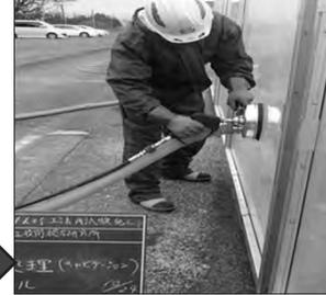
写真 CABによる下地処理実験
