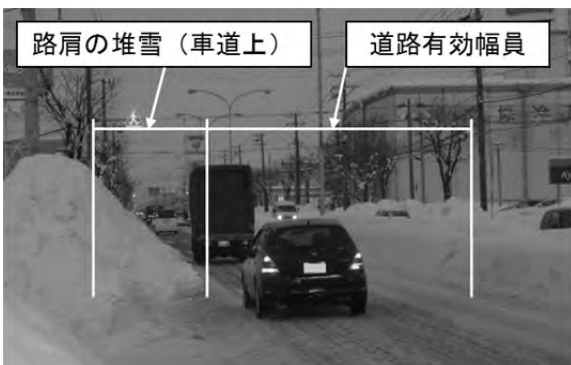
図-1 道路有効幅員と路肩の堆雪
