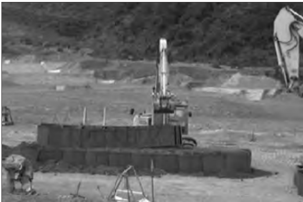
写真5 試験施工状況写真
