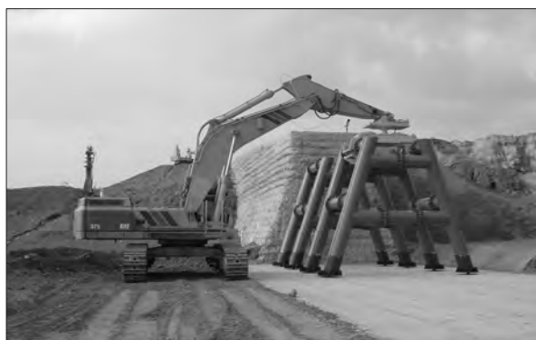
写真4 構造物(鋼製リット) 設置
