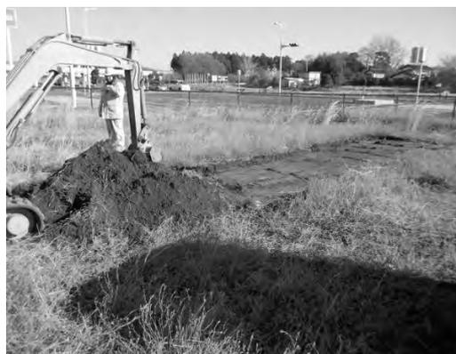
写真-3 模擬除去土壌の採取状況
