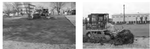
図-5 油圧ショベルとブルドーザー作業状況
