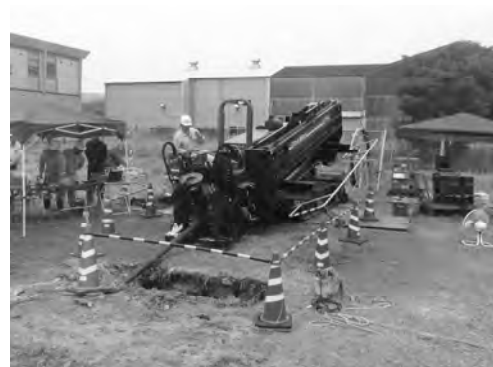
写真-3 現地試験全景 (下関)
