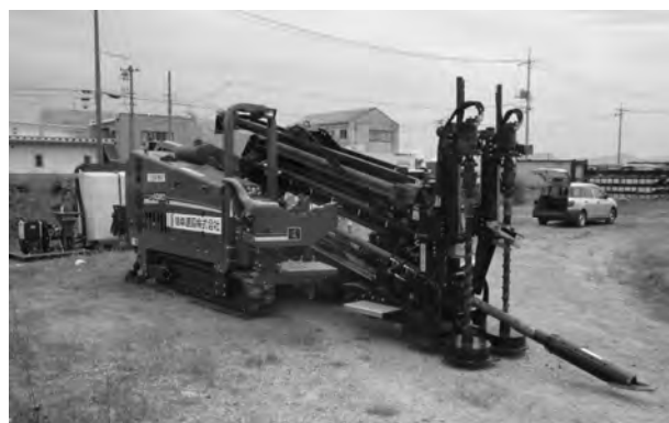
写真-1 曲り削孔機 1)
