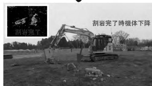
Step4 割岩作業と割岩判定
