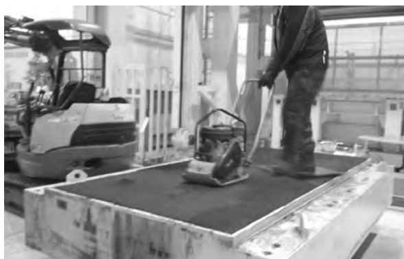
図-10 基層締固め
