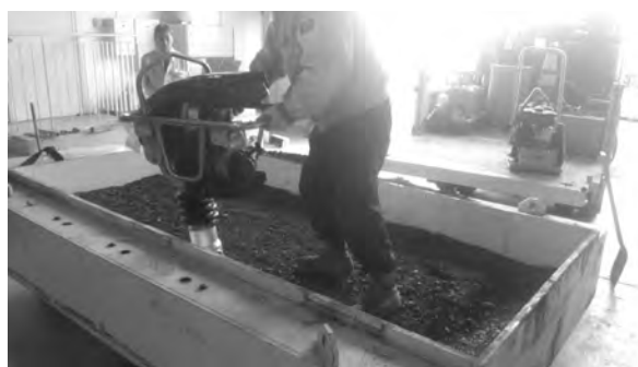
図-5 路盤締固め
