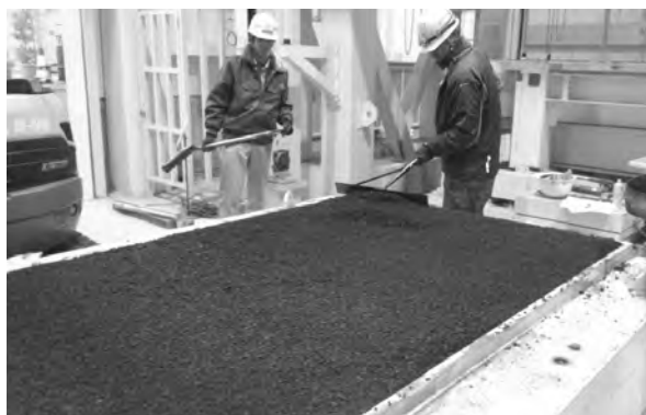
図-9 基層敷均し
