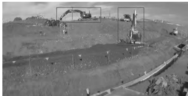
図8 背景差分法による物体検出（人には緑色の投影方形、重機には赤色の矩形表示をして分別表示）
