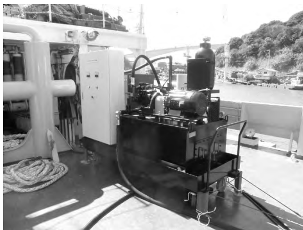
写真-5 油圧ユニット 艀装状況
