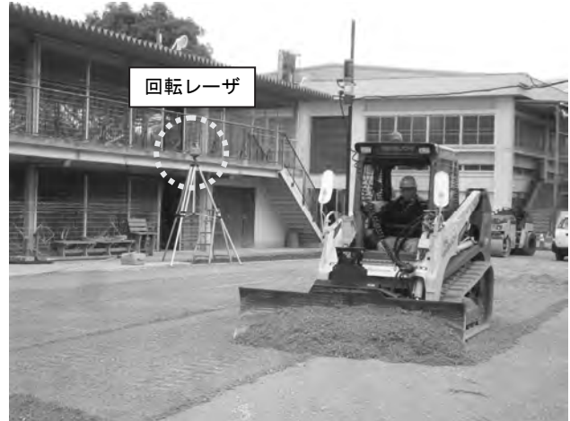
写真-7 施工状況 (2DMC)
