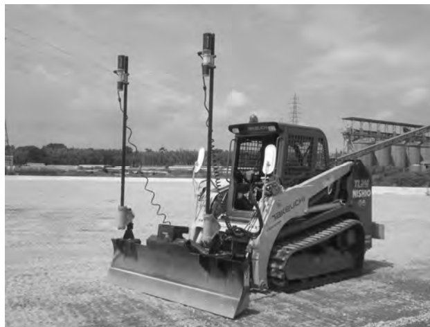
写真-11 デュアルマスト設置状況
