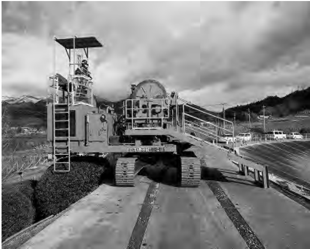
写真-1 定張力 SWP 全景
