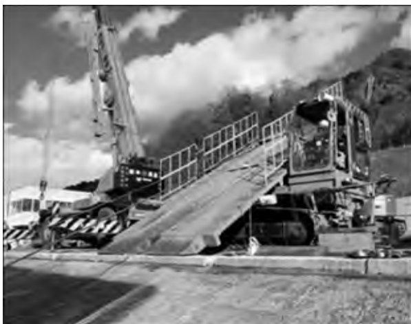
写真-4 MWP 全景
