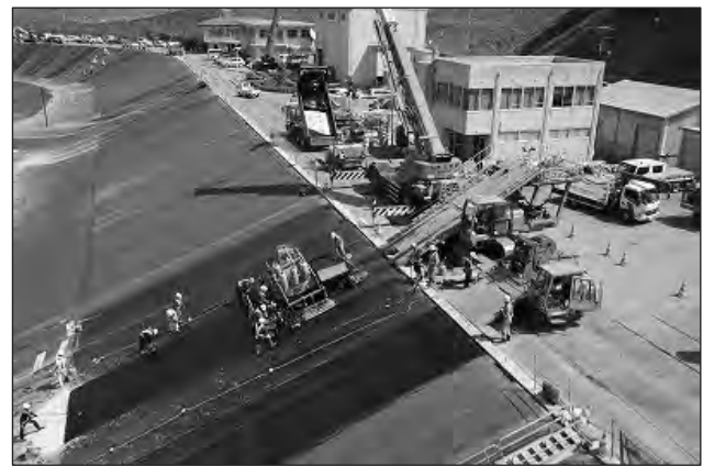
写真-7 斜面舗装施工状況全景
