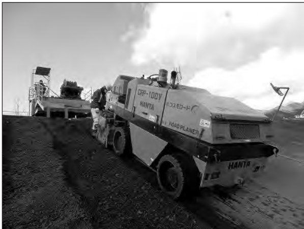
写真-2 切削機使用状況
