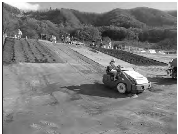
写真-3 スイーパーによる清掃作業状況
