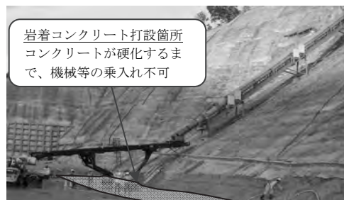
写真-1 SP-TOM 先端に自走式ベルコンを配置(嘉瀬川ダム)
