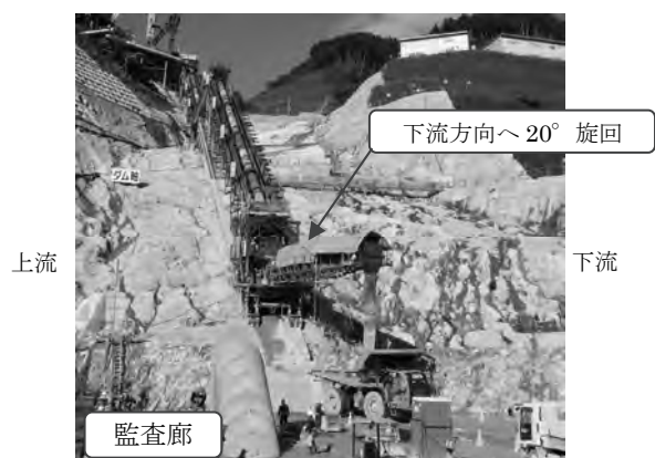
写真-6 インクライン BC 障害物回避状況
