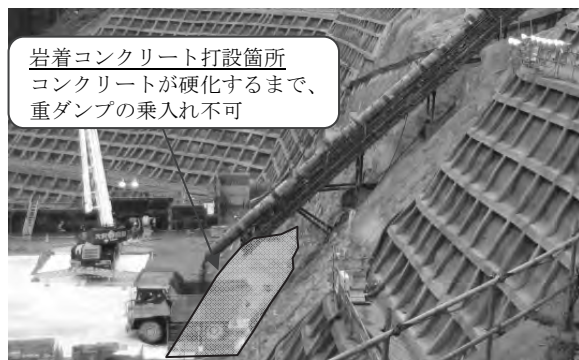
写真-2 SP-TOM 先端直下に重ダンプ配置（湯西川ダム）
