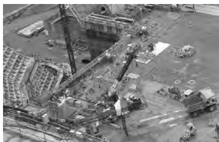
写真-4 固定式ベルコンをずらして配置（湯西川ダム）
