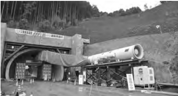
写真-3 坑口部の状況
