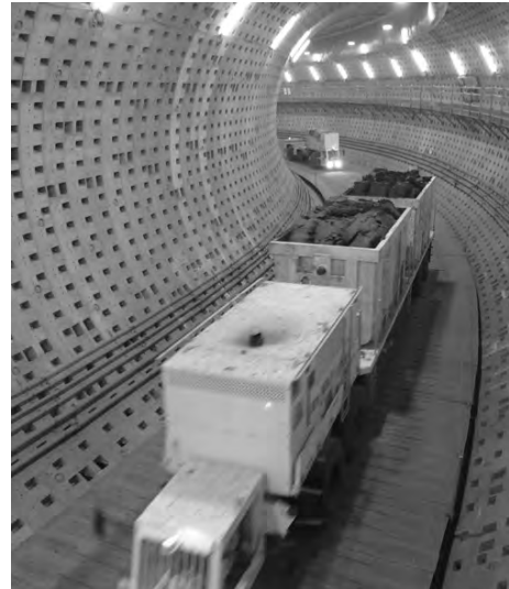
図-7 坑内急曲線走行状況
