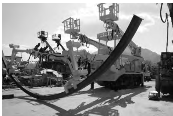
写真-3 インバート支保工接合実験
