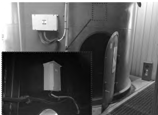
写真-9 危険エリアに設置した磁界発生装置(合材サイロ内)
