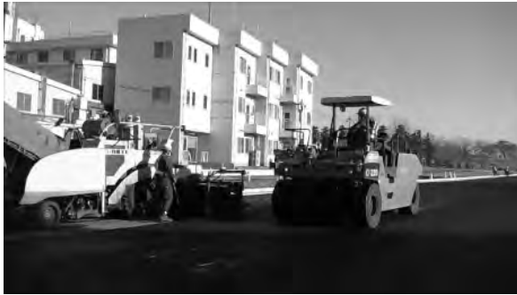
写真-4 現場での稼働状況
