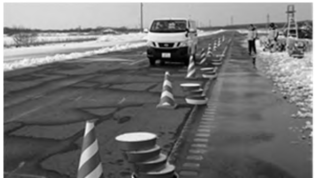
写真-3 RFID試験状況
