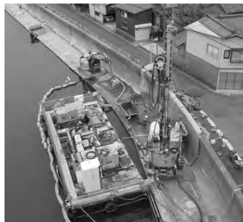
写真-3 特殊堤における施工状況
