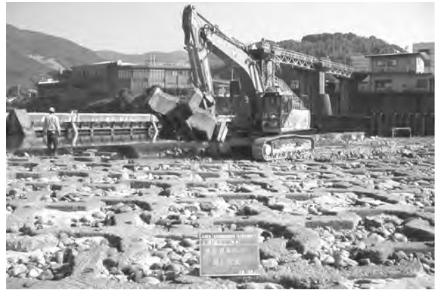
写真-3 持ち上げ作業
