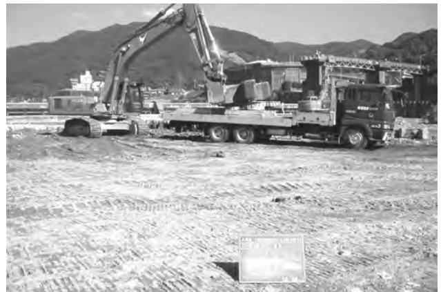
写真-4 積込作業
