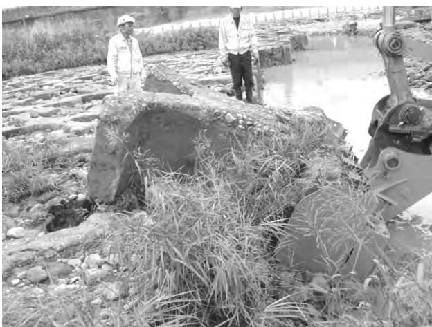
写真-2 掘り起こし作業
