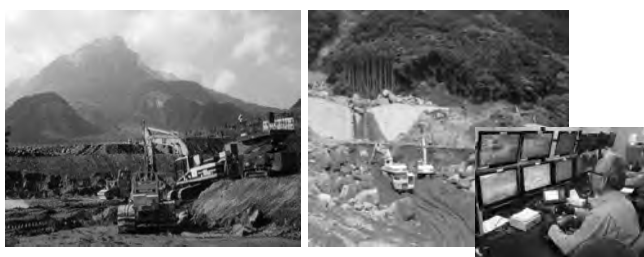
雲仙普賢岳無人化施工 南大隅深層崩壊無人化施工 写真-1 無人化施工例 1)
