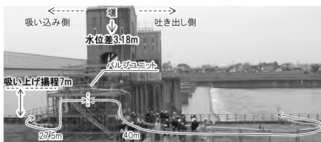
写真-7 現場検証状況(多摩川ニヶ領宿河原堰)
