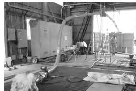
写真-6 排水実験状況
