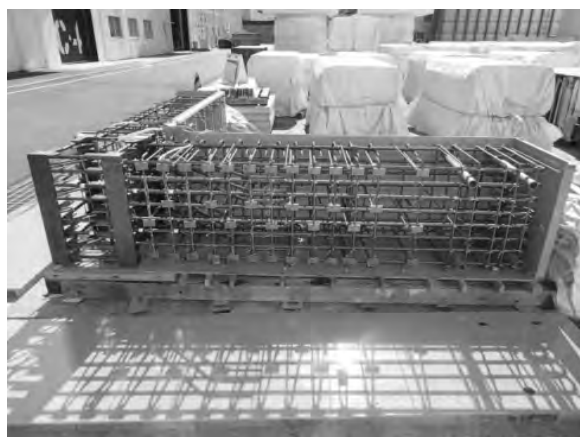
写真-3 鉄筋組立完了
