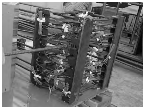
写真-2 鉄筋接続状況
