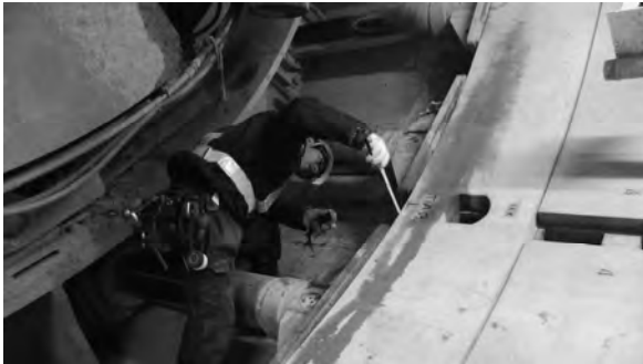
図-2 従来のテールクリアランス計測状況
