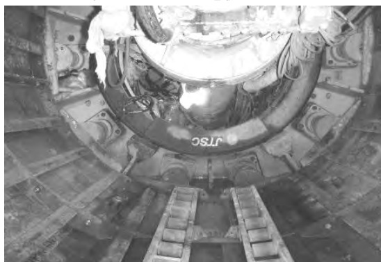
図- 18 FH ブラシシールを使用した施工状況
