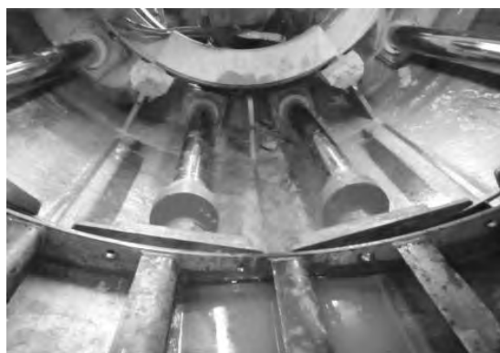
図- 17 従来のシール材を使用した施工状況
