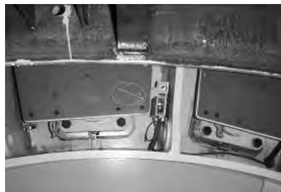
図-6 計測ユニット設置状況
