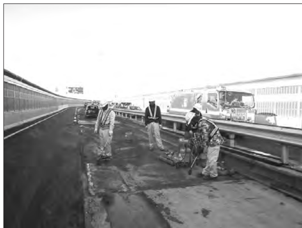
写真-2 ガスバーナを使用しての路面乾作業
