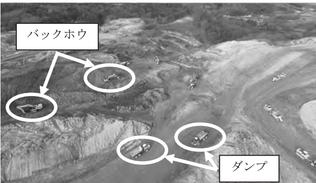
図-5 現場重機の往来状況
