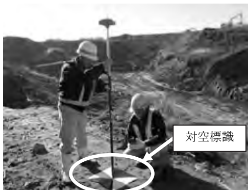
図-9 対空標識の GNSS 測量状況
