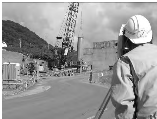
図-2 基礎杭中心座標の計測風景
