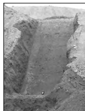
写真-1 掘削現場の写真
