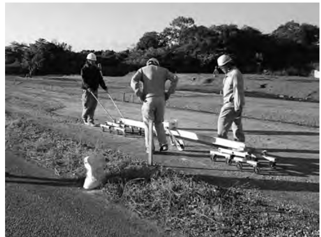
図-4 平坦性測定状況
