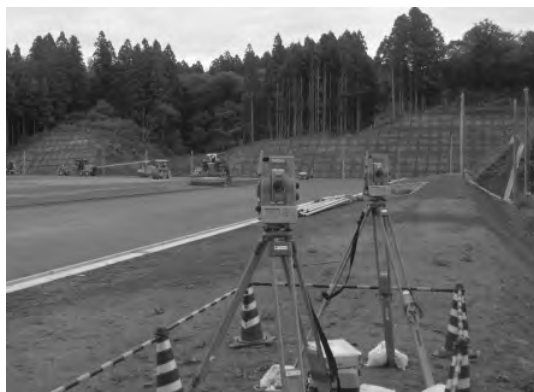
写真-2 施工状況
