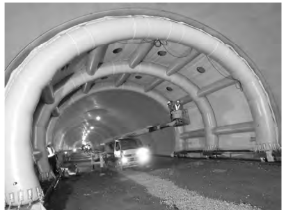
写真-5 ノズル・ホース設置状況
