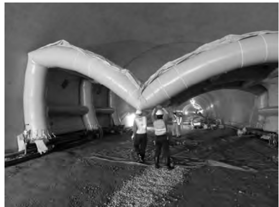
写真-4 空気注入状況
