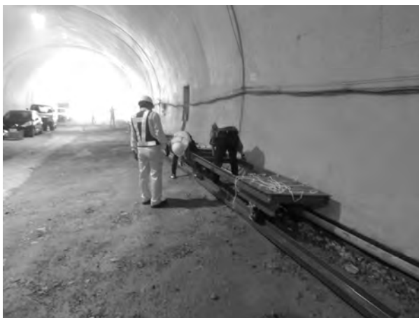
写真-2 レール・台車設置
