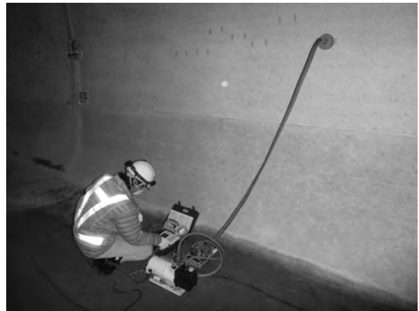
写真-7 透気性試験状況
