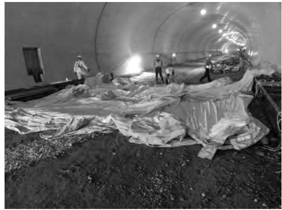
写真-3 エアフレーム敷き広げ
