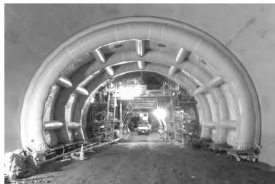
写真-6 設置完了
