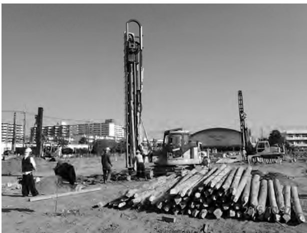
写真-1 施工状況
