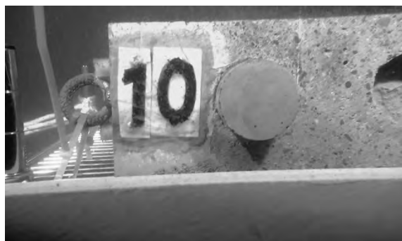
写真5-4 模擬版精査状況(弥栄ダム)
