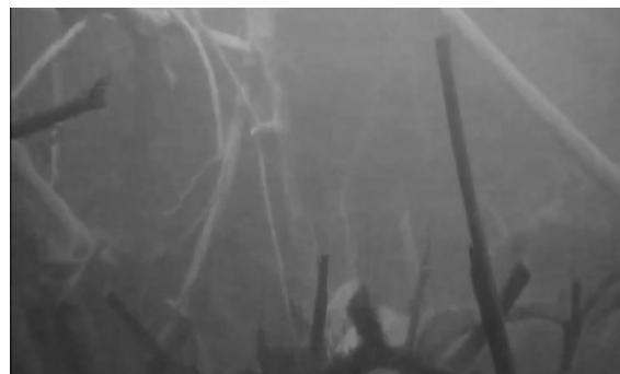
写真5-5 選択取水塔流木状況(弥栄ダム)
