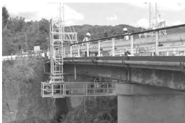
写真-3 作業状況 (2)
