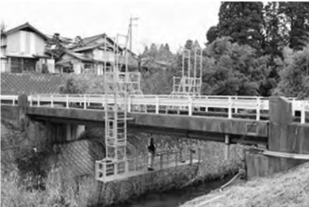
写真-6 ブリッジハンガーの設営状況
