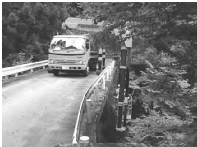
写真-1 橋梁点検車による作業状況
