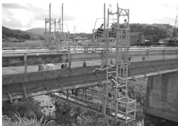
写真-2 作業状況 (1)
