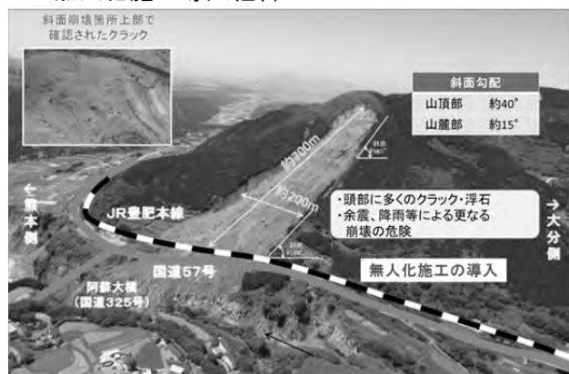
図-1 阿蘇大橋地区被災状況
