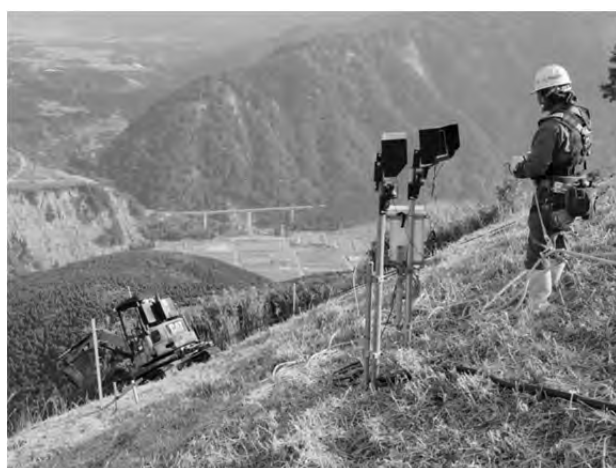
写真-1 ラウンディング遠隔操作状況
