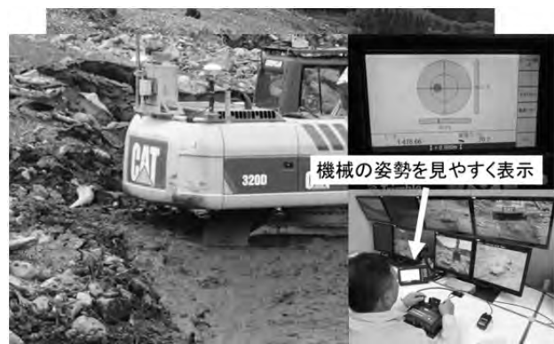
写真-5 マシンガイダンス泥濘部水平器使用状況
