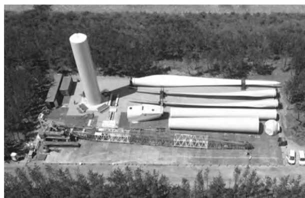
写真-3 風車部材仮置状況
