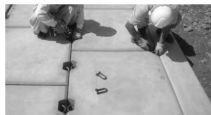
写真-4 ブロック連結作業
