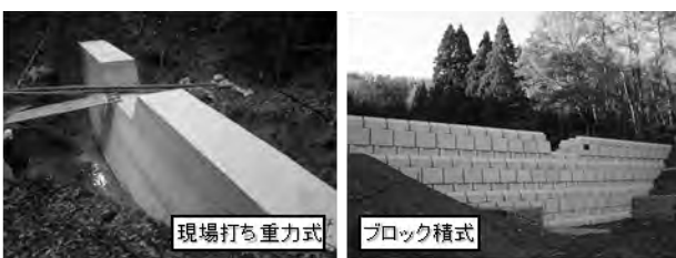
写真-2 床固工
