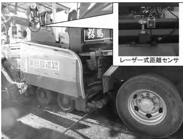
写真-9 施工状況
