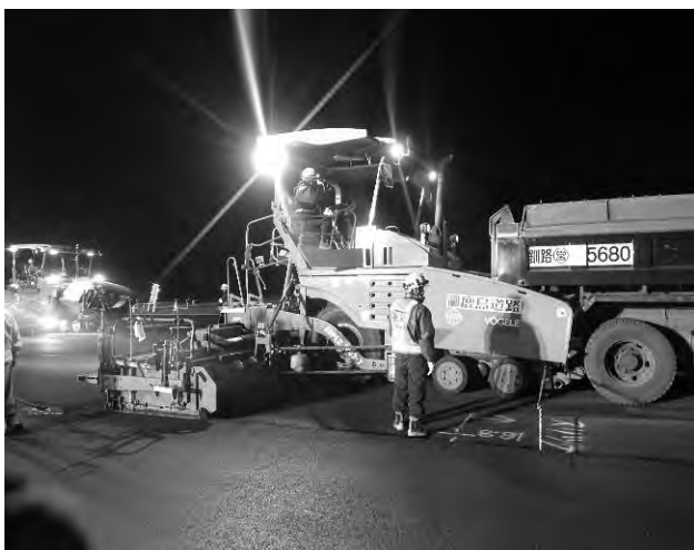
写真-2 夜間での施工状況
