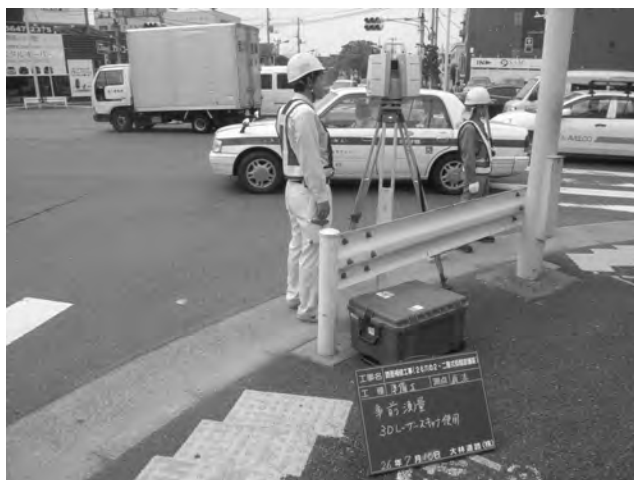
図-3 TLSによる既設路面計測状況
