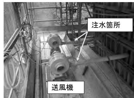
写真-3 送風設備設置状況
