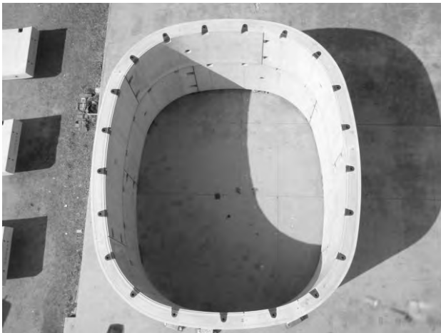
写真-1 セグメント仮組立状況
