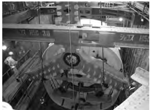
写真-4 現地組立状況
