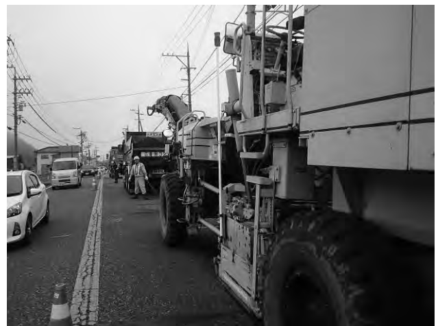
写真-2 機器取り付け状況
