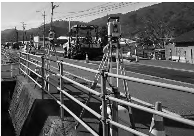
写真-1 TS設置状況
