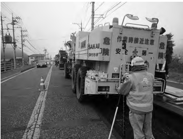
写真-3 施工状況
