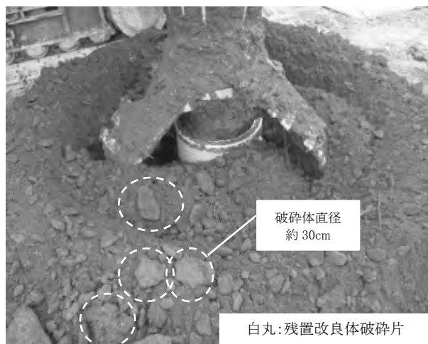
写真-2 残置改良体の破砕状況
