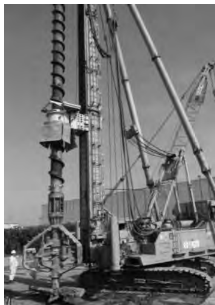
写真-3 スパイラルロッド(PIs 工法)による試験施工全景
