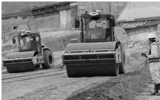
写真-3 2台の振動ローラによるコア材自動転圧
