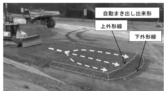
写真-5 フィルター材自動まき出し結果 (幅 10m)
