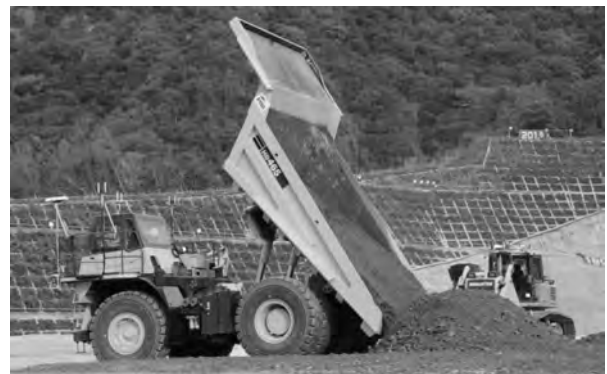
写真-7 自動化ダンプトラックと自動化ブルドーザの連携作業
