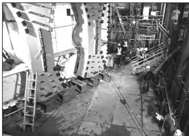
写真-5 前胴部回転状況
