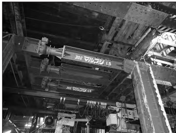
写真-7 推力伝達架台設置状況
