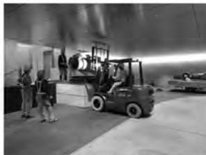
写真-11 解体材搬出状況
