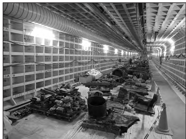
写真-10 坑内に仮置きした解体材
