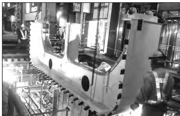
写真-4 前胴下部投入状況
