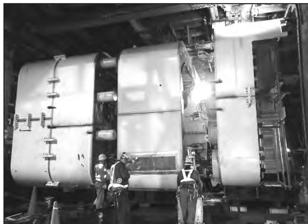
写真-6 中胴部横引き状況
