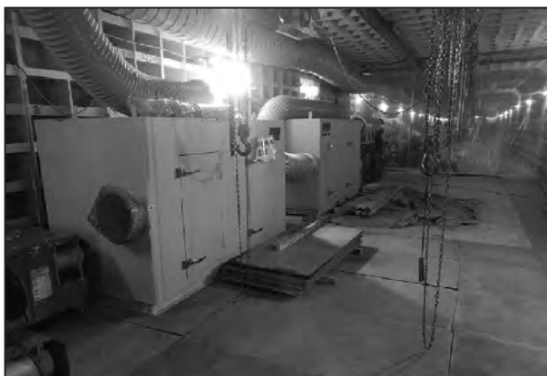
写真-9 排気浄化装置設置状況（マシン近傍）
